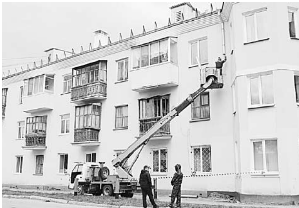
Ремонта фасада в 2023-м г. будет стоить 5,6 млн руб.
