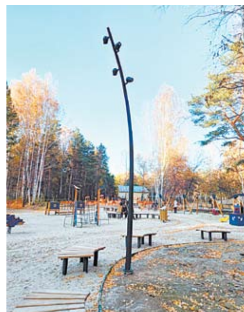
Опоры освещения от ООО НПО «Легион» установлены в Манином парке
