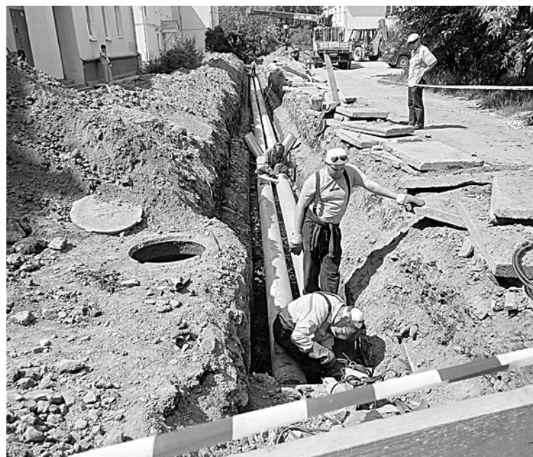
Ремонтные работы на тепловых сетях улицы Куйбышева
