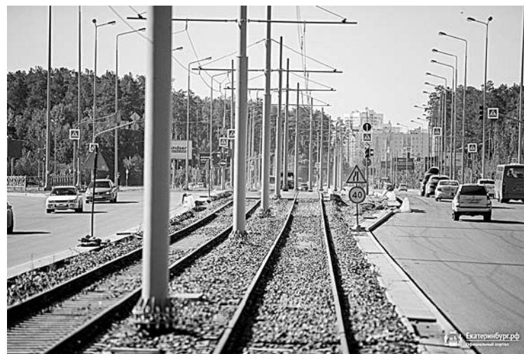
Для новой трамвайной ветки НПО «Легион» изготовило 166 опор
