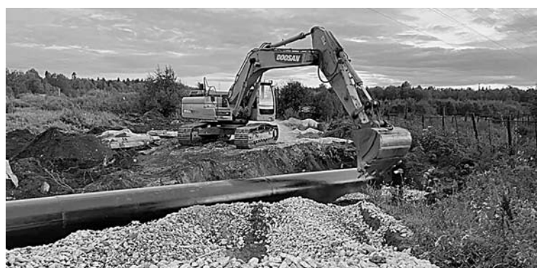
Масштабный ремонт на Бахтеева с заменой ливневой трубы
