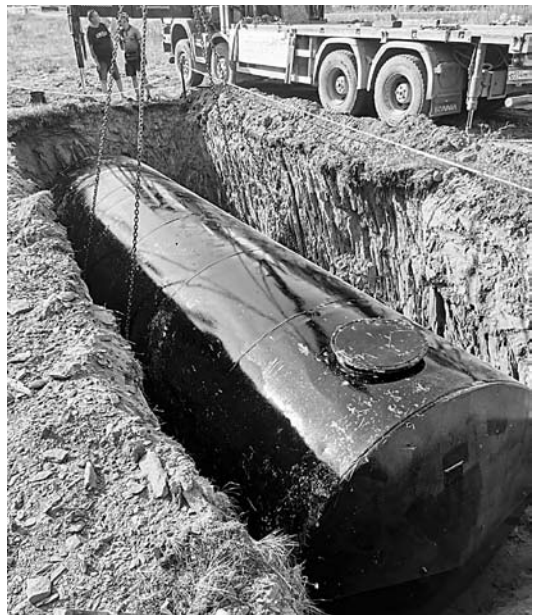
Установка емкости для тушения пожаров
