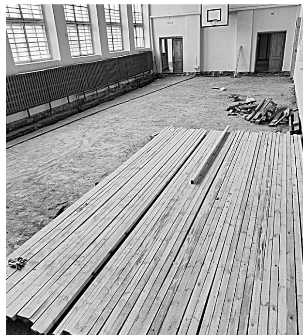
После ремонта пола спортзал полностью обновится
