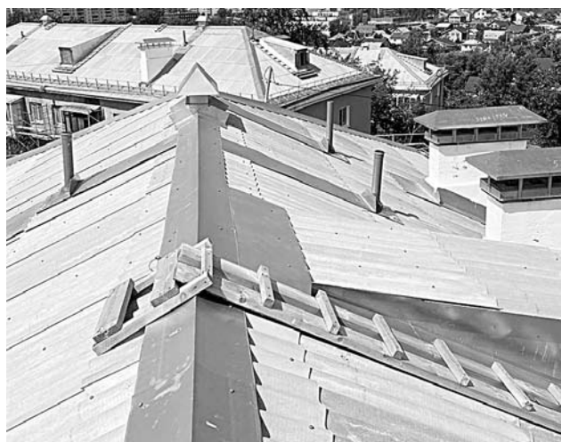
Напремонт – подведены промежуточные итоги
