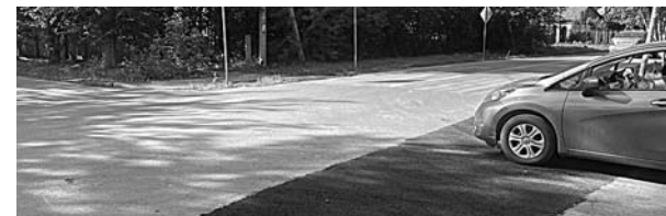
Перекресток Куйбышева-Уральская отремонтировали
