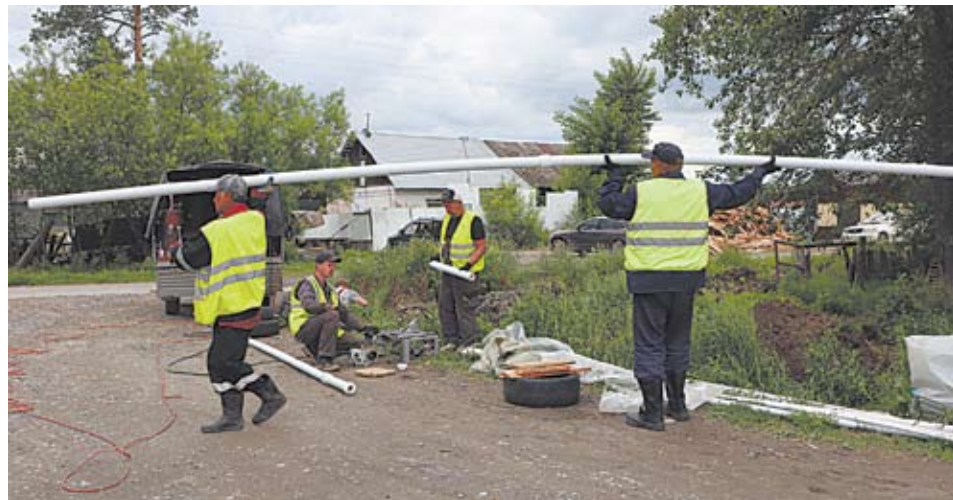
Вместо старых металлических сетей – новые пропиленовые трубы
