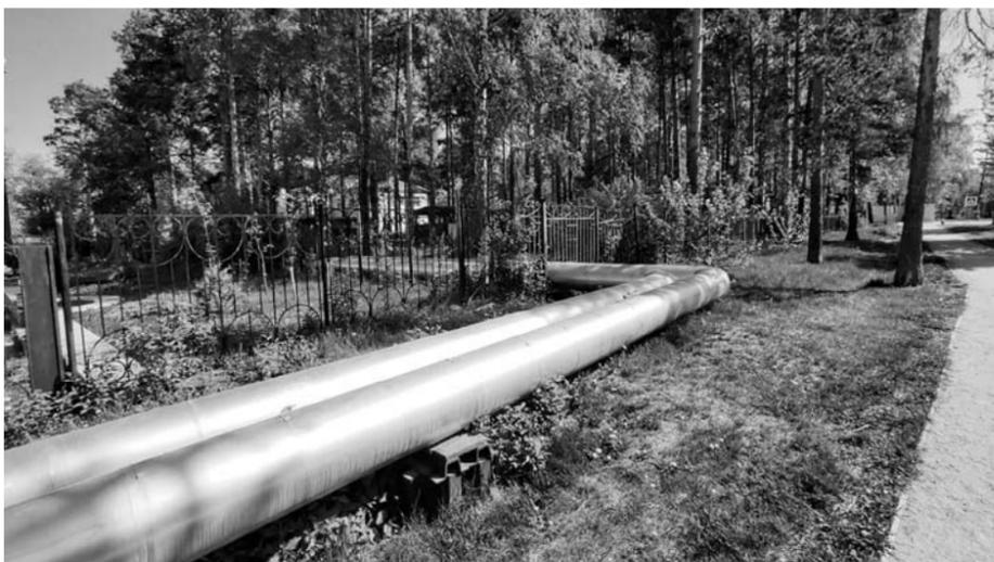
«Окожушивание» – восстановление изоляции – запланировано на 2 км теплотрассы
