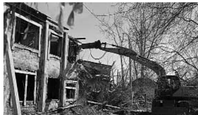
Снос дома №8 был выполнен технично и оперативно
